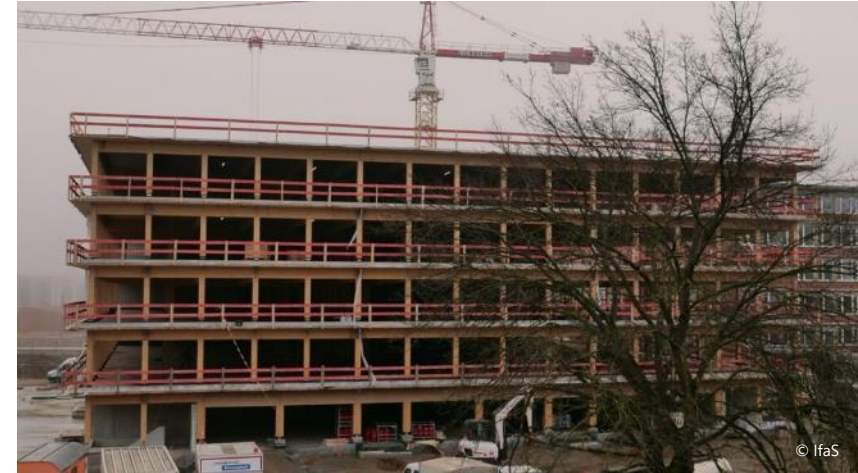
Im Bau befindliches Holzparkhaus. Stand Februar 2024
