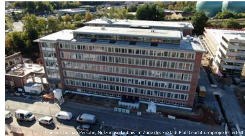
MVZ im Pfaff-Quartier - Dachaufstockung in Holzbauweise
